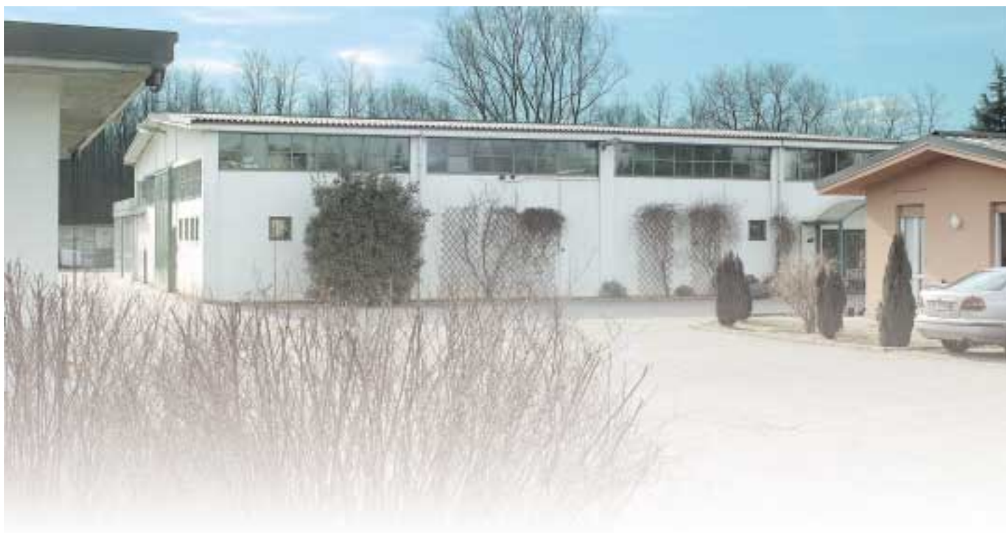
Briosco (MI) - stabilimento n° 1 Briosco (MI) - plant n° 1 Briosco (MI) - établissement n° 1
